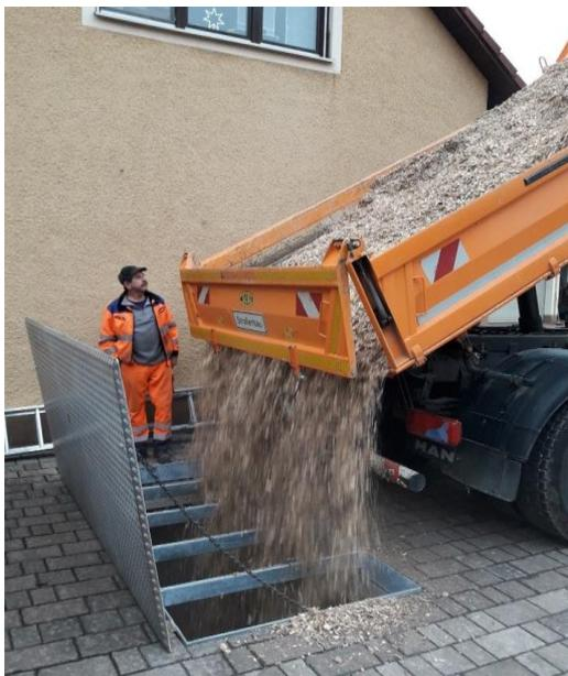
Erstbefüllung des Hackgut-Bunkers mit Hackschnitzel
