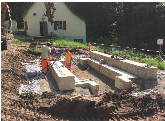
Einbau der Dolomit-Natursteinquader; im Hintergrund das Pumpenhaus der Wasserversorgung Pottenstein
