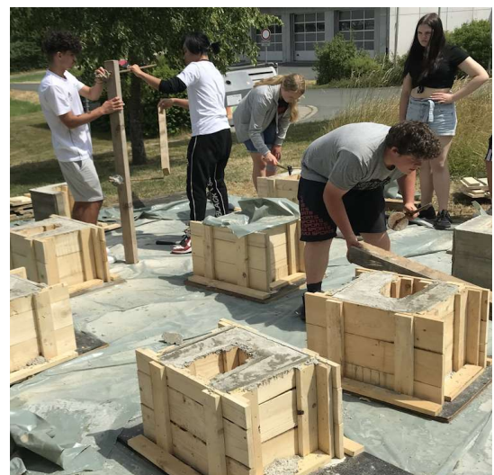
Nach dem Austrocknen muss die Schalung wieder ab.
